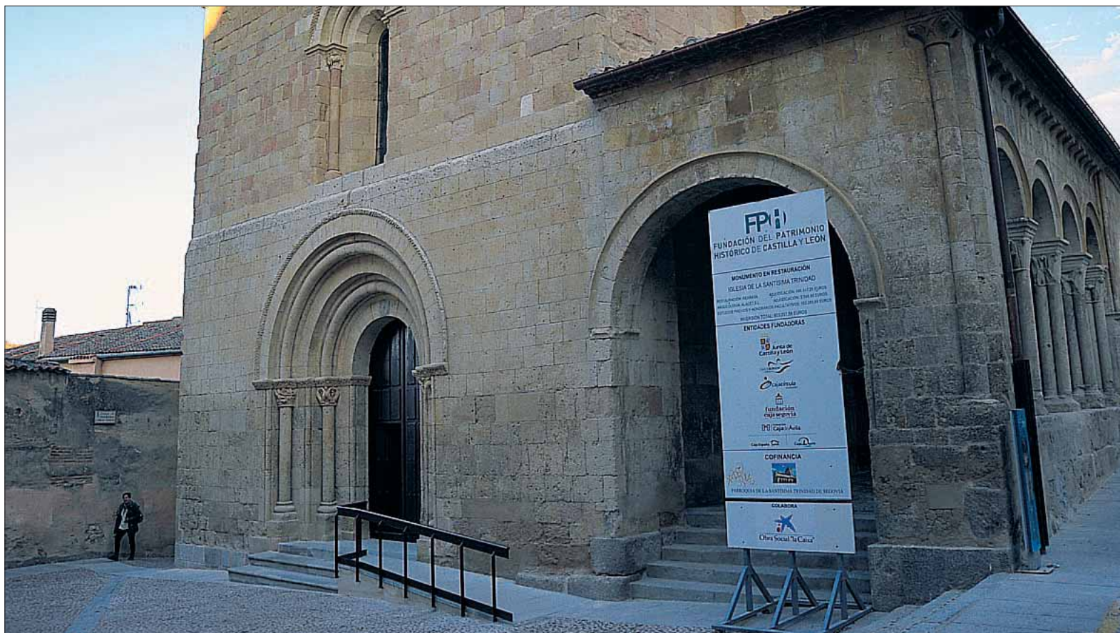
La fachada del templo muestra ya el renovado aspecto tras la intervención de restauración realizada en el inmueble. / KAMARERO
