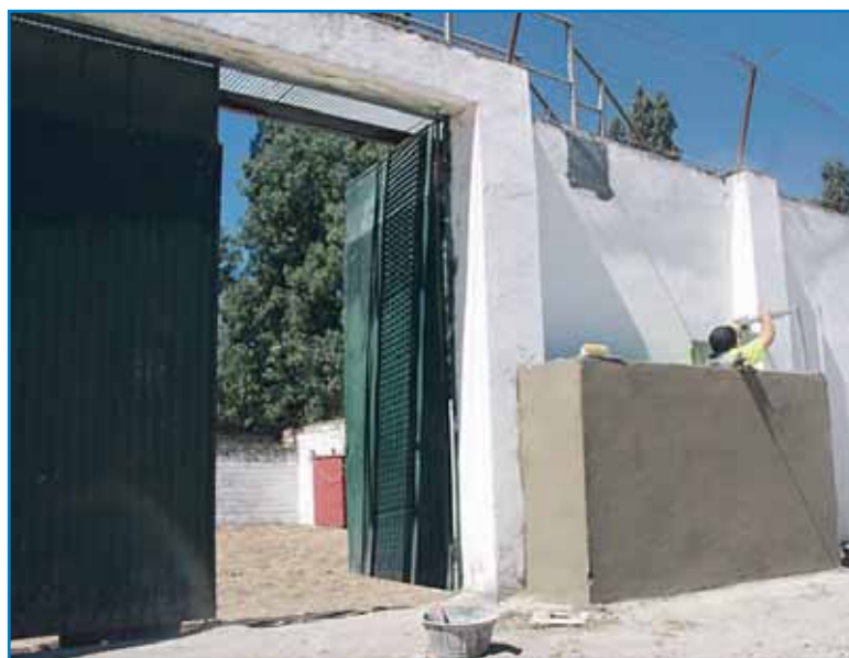
Construcción del nuevo burladero en la puerta de los corrales. / C.N.
