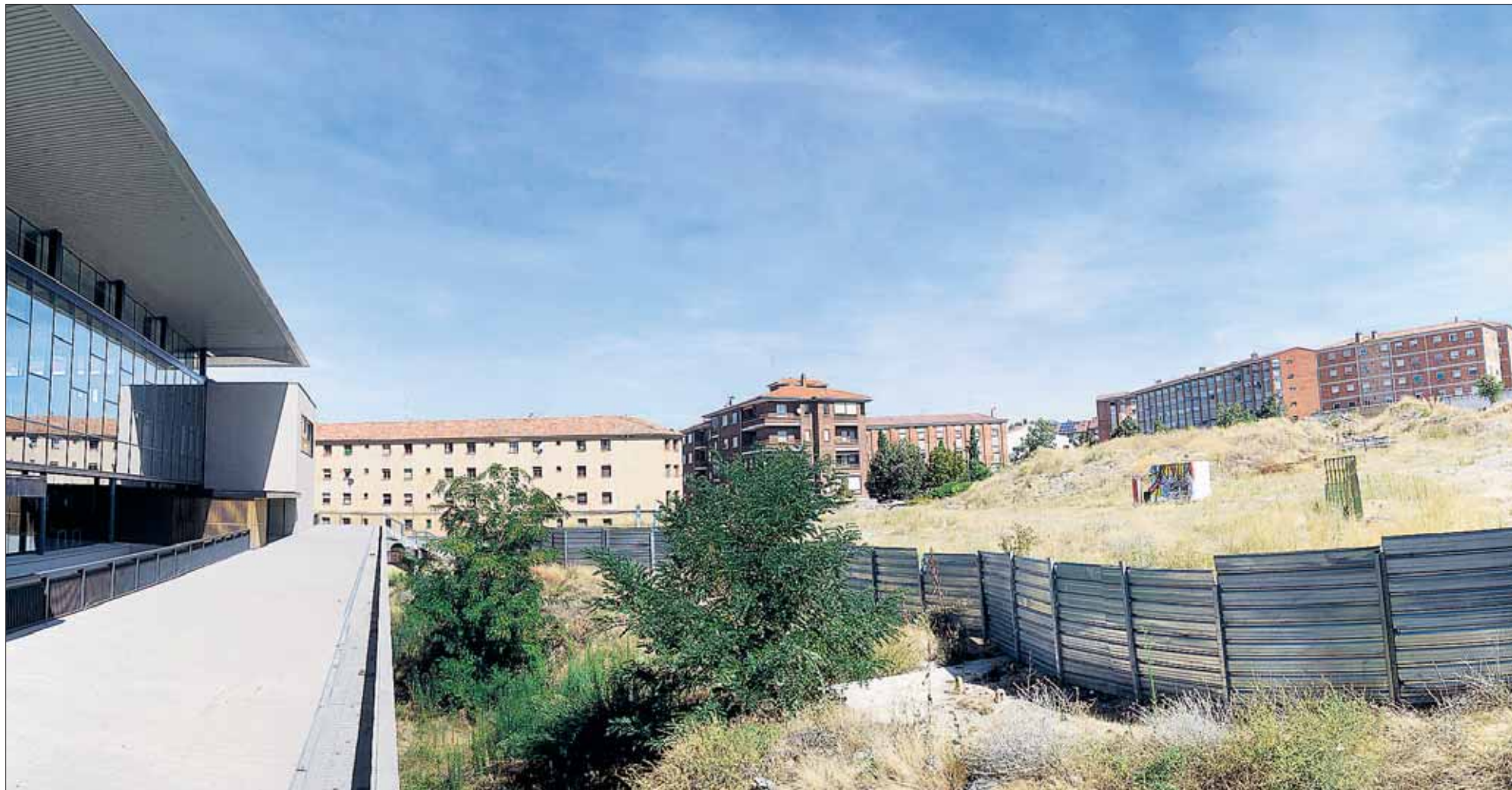
Imagen del terreno, anejo al edificio del campus 'María Zambrano' ya en uso, que a partir del miércoles será sometido a trabajos de limpieza y desescombro. / KAMARERO
