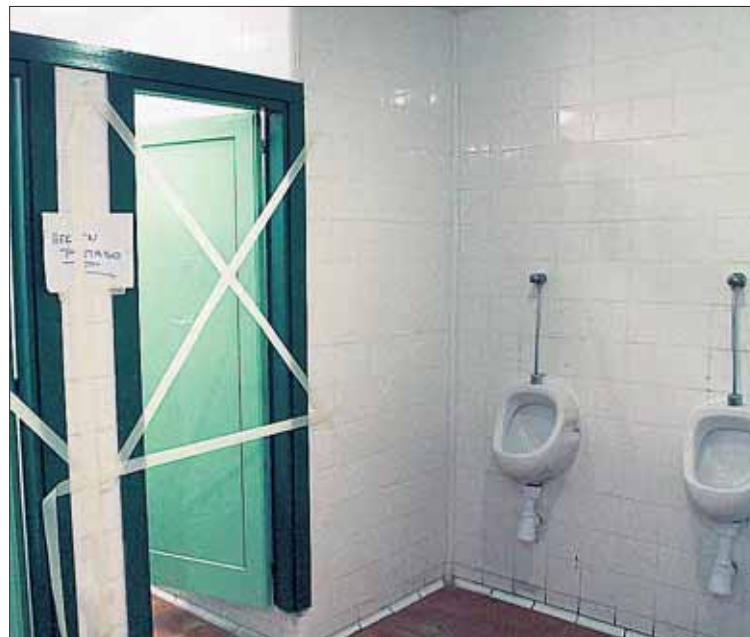
Los nuevos urinarios han sido ya instalados y las puertas han sido reparadas. / M.G.
