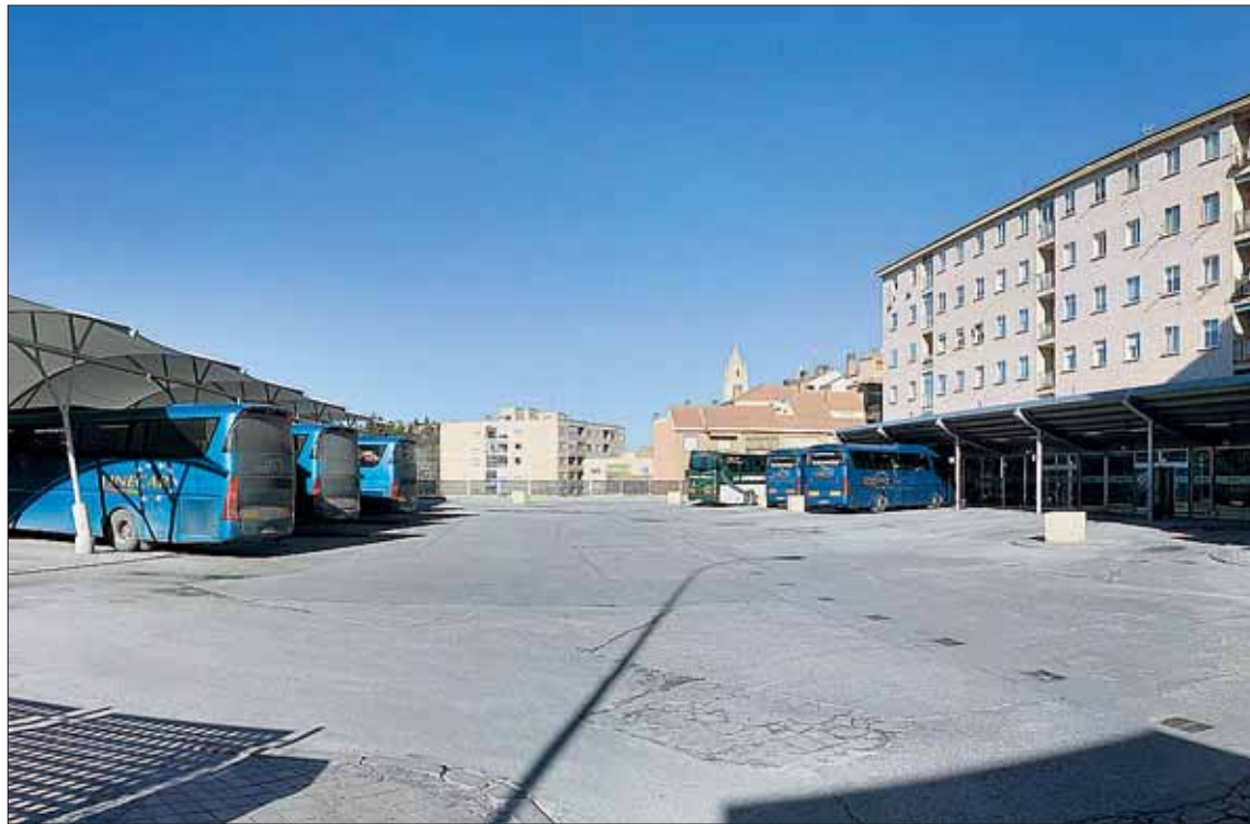
La prueba de carga es un paso previo a las obras de remodelación y determinará si el forjado de la campa es apto. / KAMARERO
