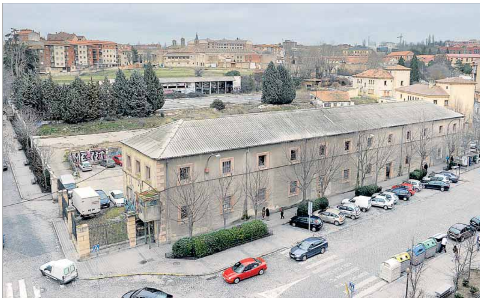
El Ministerio de Defensa mantendrá la propiedad del edificio con fachada a la plaza de la Universidad. / KAMARERO
