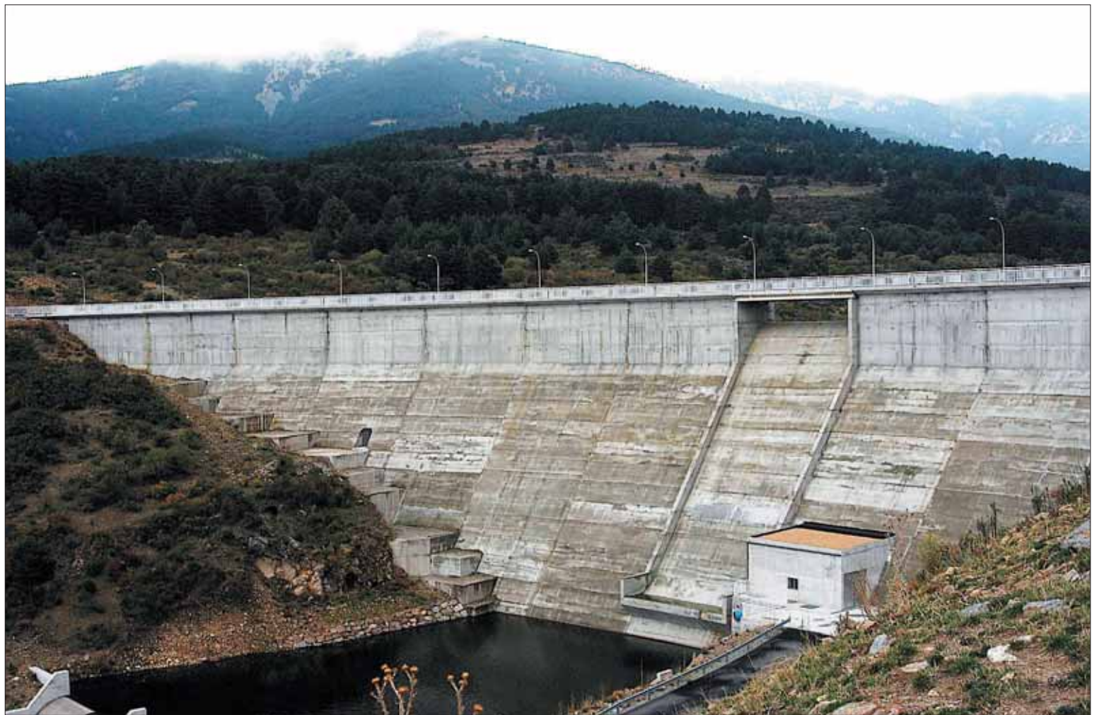
Pantalla de la presa del río Ceguilla, situada en el término municipal de Aldealengua de Pedraza, en una imagen de archivo. / GUILLERMO HERRERO
