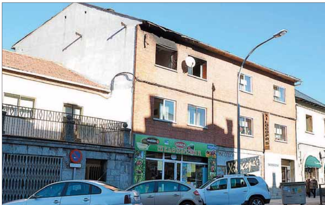
La vivienda quemada es el segundo piso de este edificio de la avenida Alto de los Leones. / PEDRO L. MERINO
