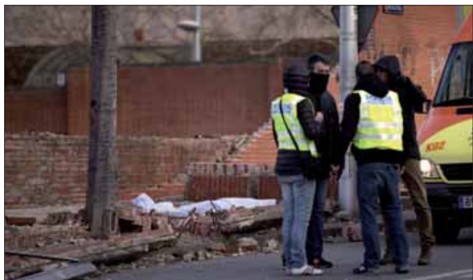
Efectivos de la Policía junto a los escombros de un muro derribado. / EFE
