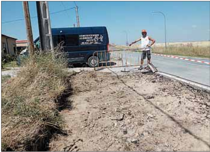
Estado actual del margen de la carretera. / L.M.
