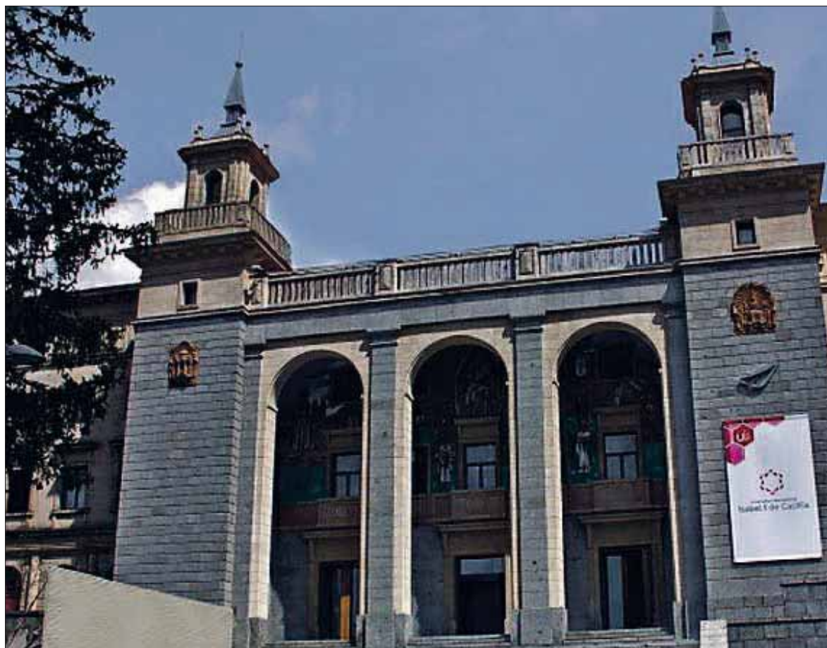
Fachada principal de la sede central de la Universidad Isabel I, en el centro histórico de la ciudad de Burgos. / AGENCIAS
