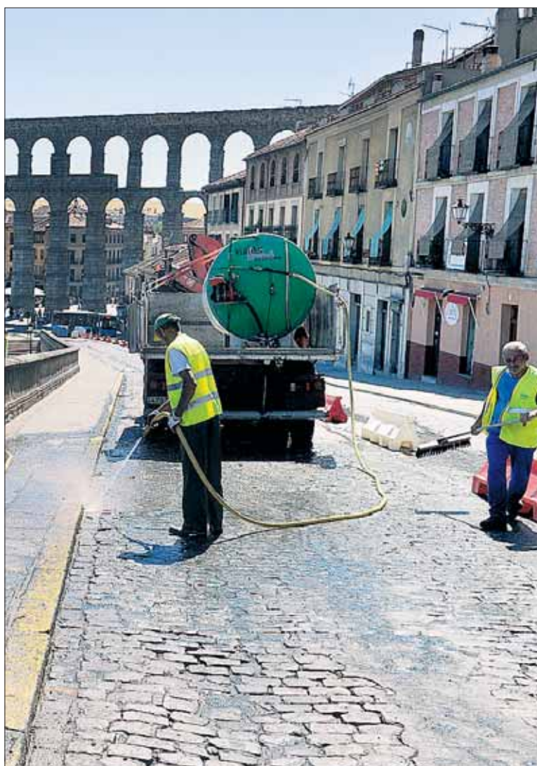
Operarios trabajando ayer en la calle de San Juan. / KAMARERO
