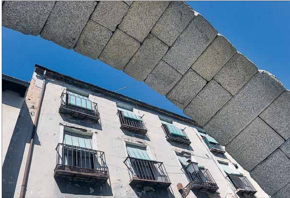
El barrio de El Salvador creció al amparo del Acueducto. El monumento, en su trazado por la calle Almira. / KAMARERO
