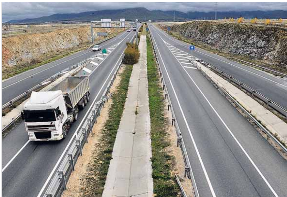
Vista parcial de la carretera SG-20. La licitación de las obras de su desdoblamiento está prevista para este año. / KAMARERO
