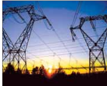
Un tendido eléctrico.
