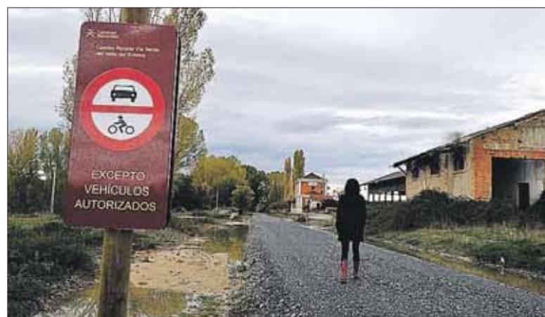
Imagen de una zona del camino que está recuperándose. / KAMARERO
