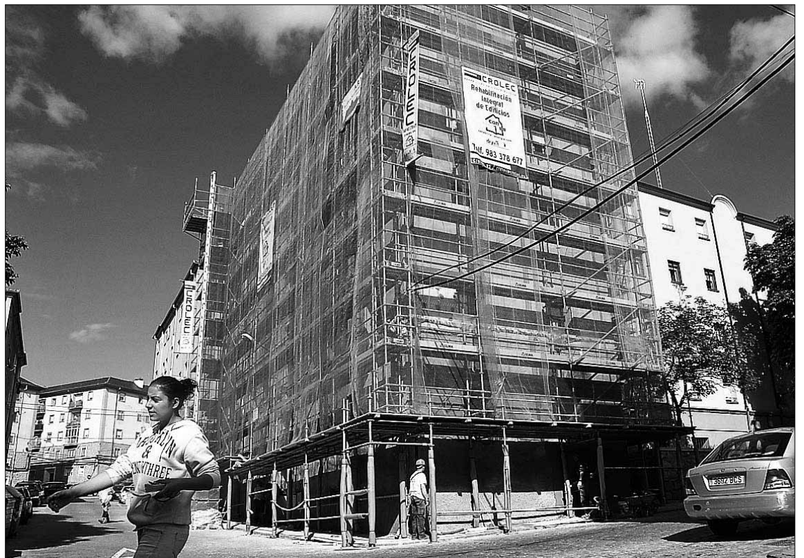
Las obras de rehabilitación continúan a buen ritmo, según las previsiones. / JUAN MARTÍN
