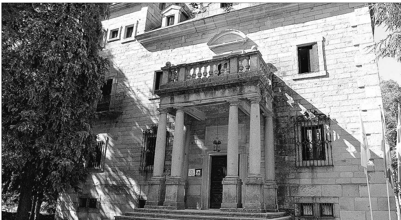
Entrada al albergue Alto del León, que junto al campamento juvenil está previsto que abran el próximo verano. / PEDRO L. MERINO
