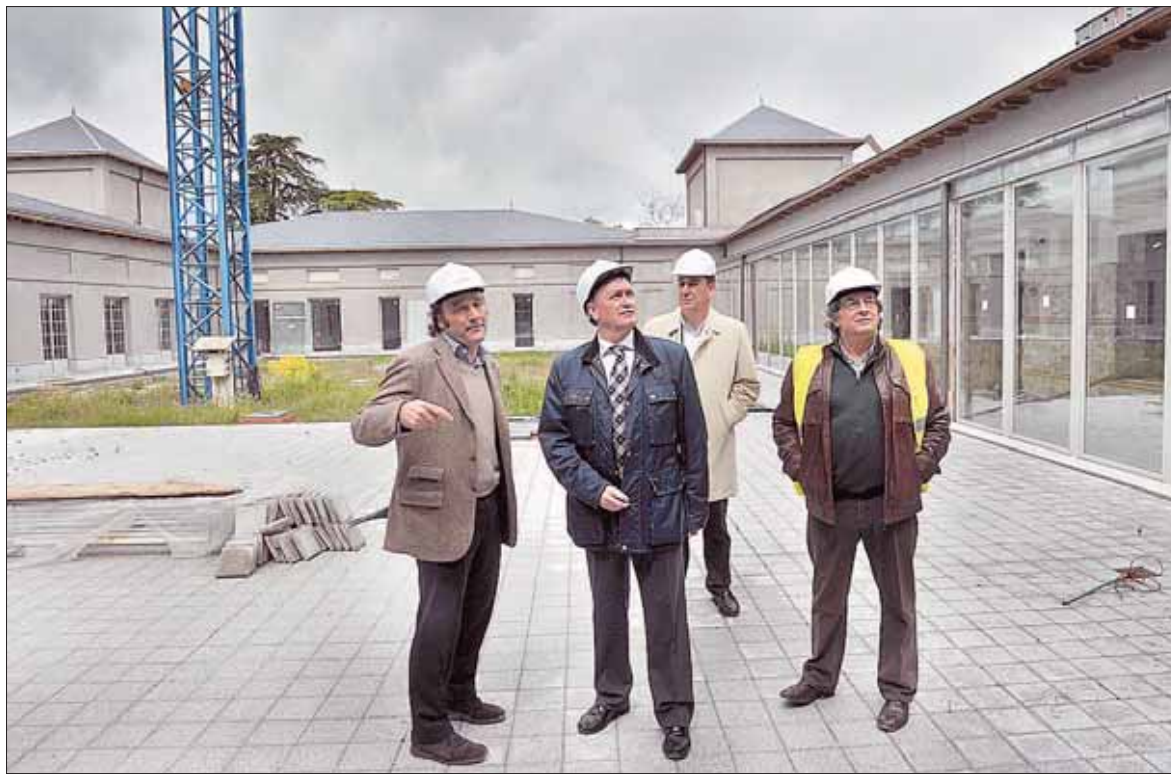
El arquitecto de la obra y el presidente de la Diputación observan, con otros asistentes la marcha de los trabajos. / KAMARERO
