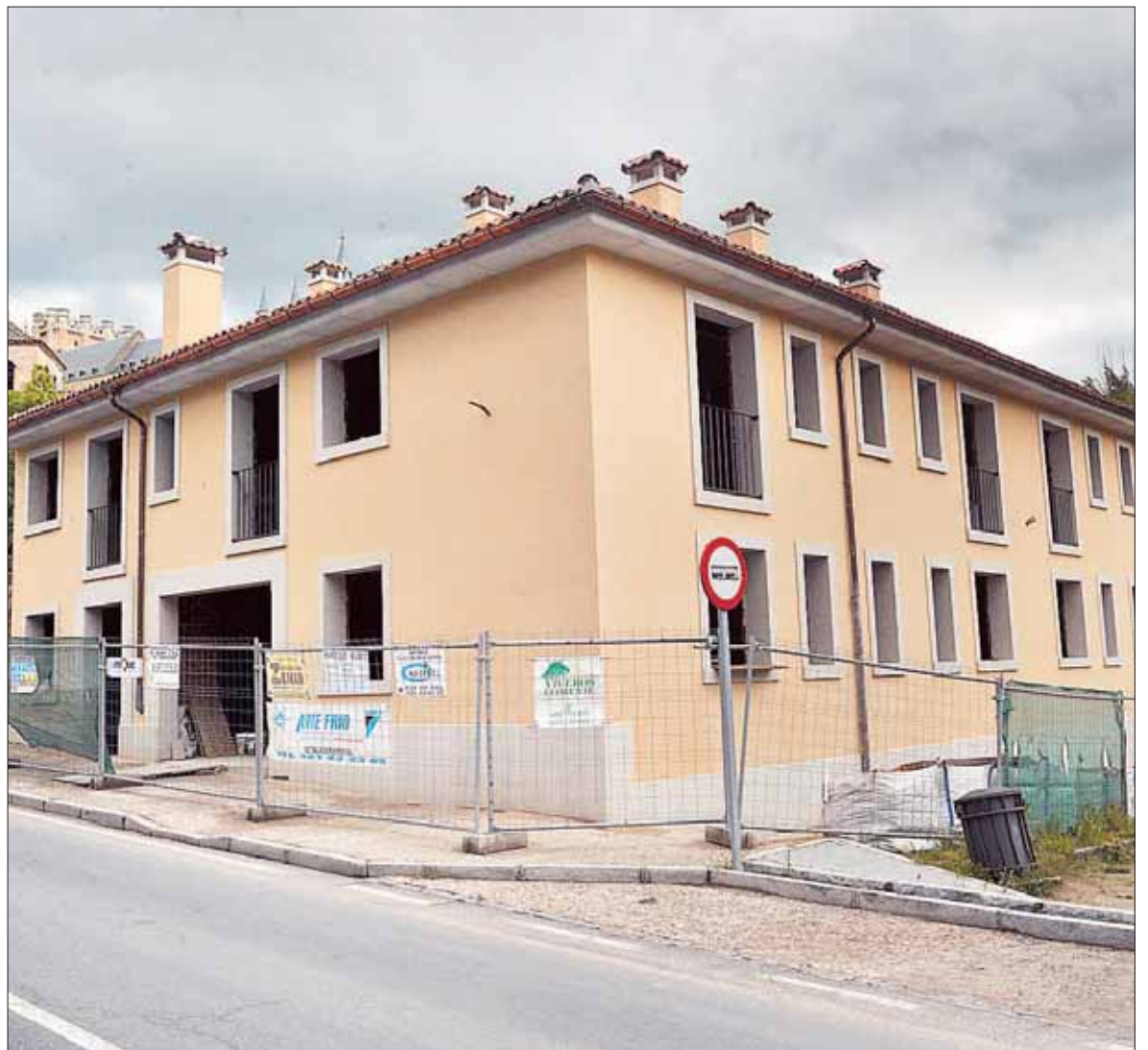
El polémico edificio en construcción se sitúa a la altura del número 25 de la calle de San Marcos. / KAMARERO
