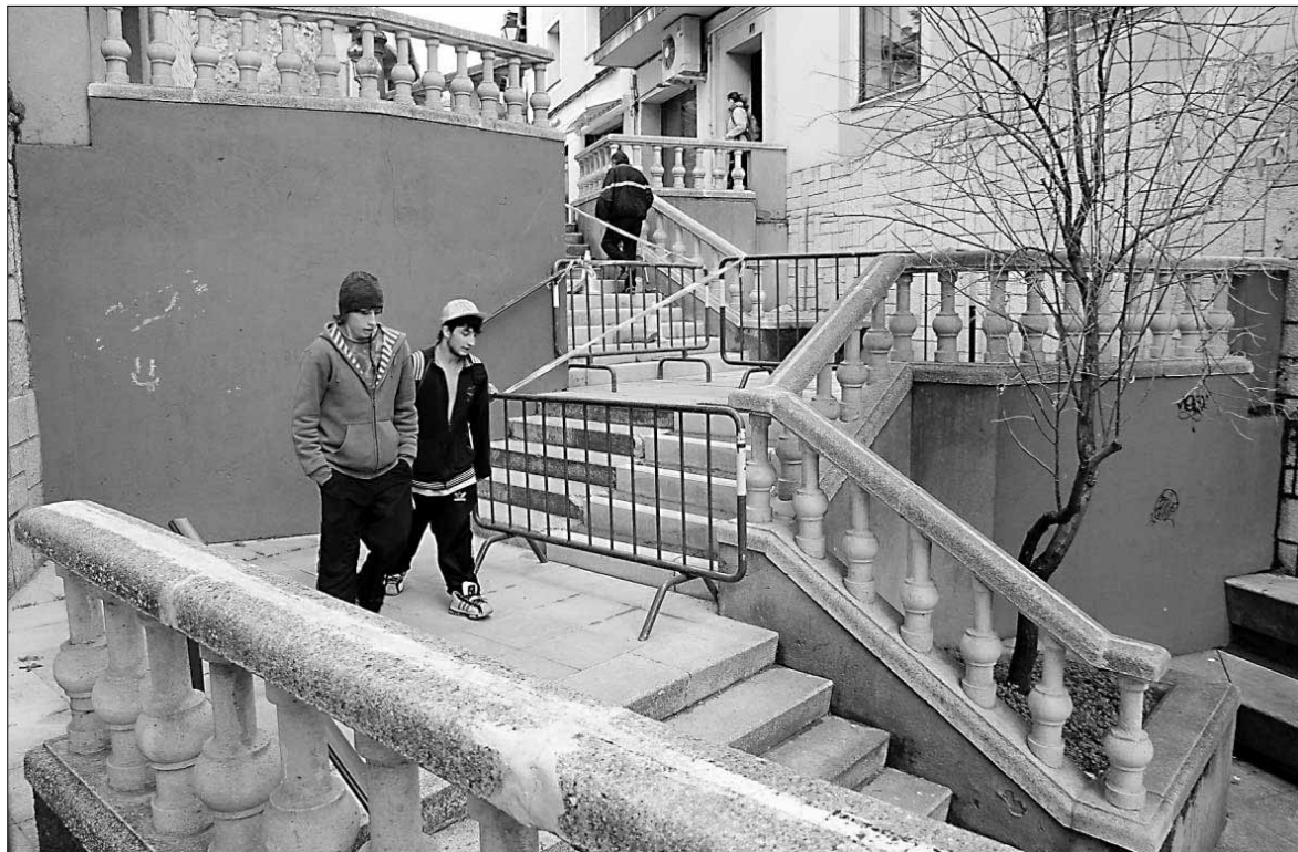
Estado actual de los trabajos de adecuación de las escaleras que se están realizando./GABRIEL GÓMEZ
