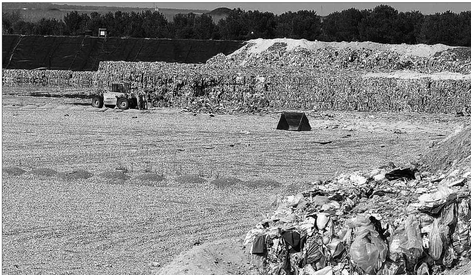
El nuevo vaso del centro de rechazos tendrá una capacidad aproximada de 358.000 metros cúbicos. / JUAN MARTÍN
