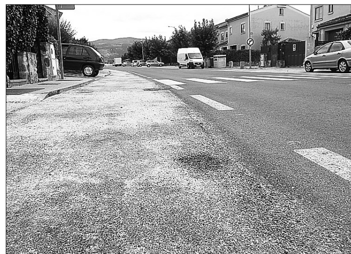
Los trabajos se han efectuado en varias calles. / EL ADELANTADO
