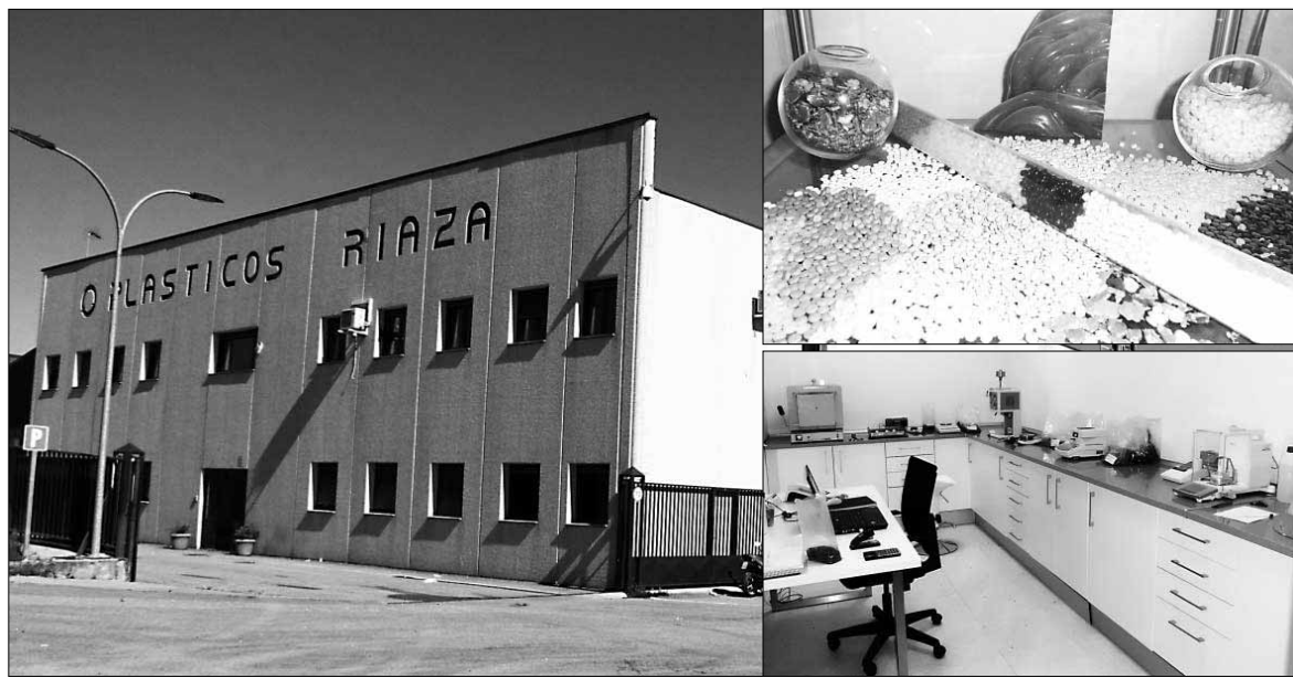
Instalaciones de Plásticos Riaza / ARCHYBOX
