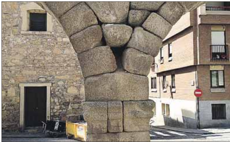
La foto muestra el boquete que existe en el Acueducto. / EL ADELANTADO
