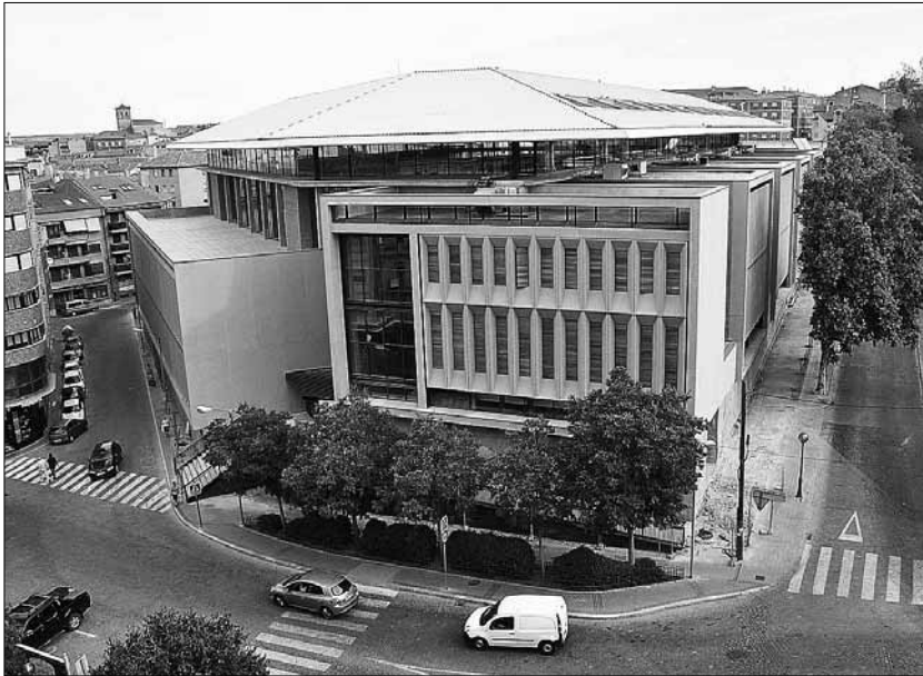
Edificio construido en la primera fase de obras del campus "María Zambrano" de la Universidad de Valladolid. / JUAN MARTÍN
