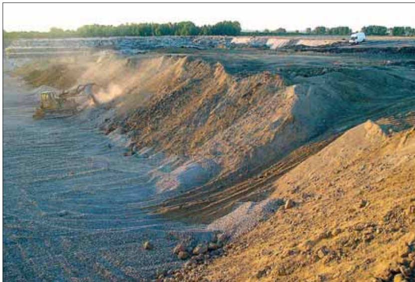
Depósito de 'rechazos' de Martín Miguel, que será próximamente sellado, en una imagen de archivo. / JUAN MARTÍN
