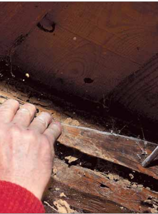
Comprobar que los insectos han ido convirtiendo en serrín la madera. / KAMARERO
