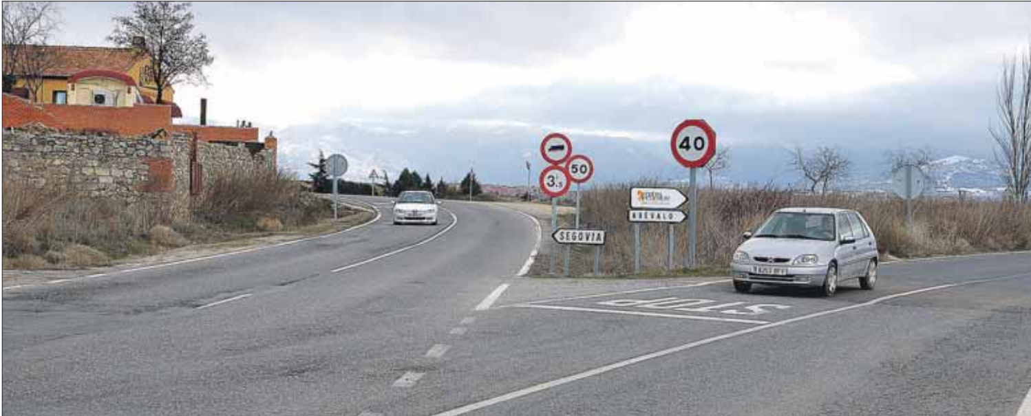
Cruce de la variante de Zamarramala con la carretera del antiguo vertedero del Peñigoso. En la futura glorieta confluirán estas dos vías y una nueva calle de acceso al barrio incorporado, que se abrirá detrás del restaurante La
