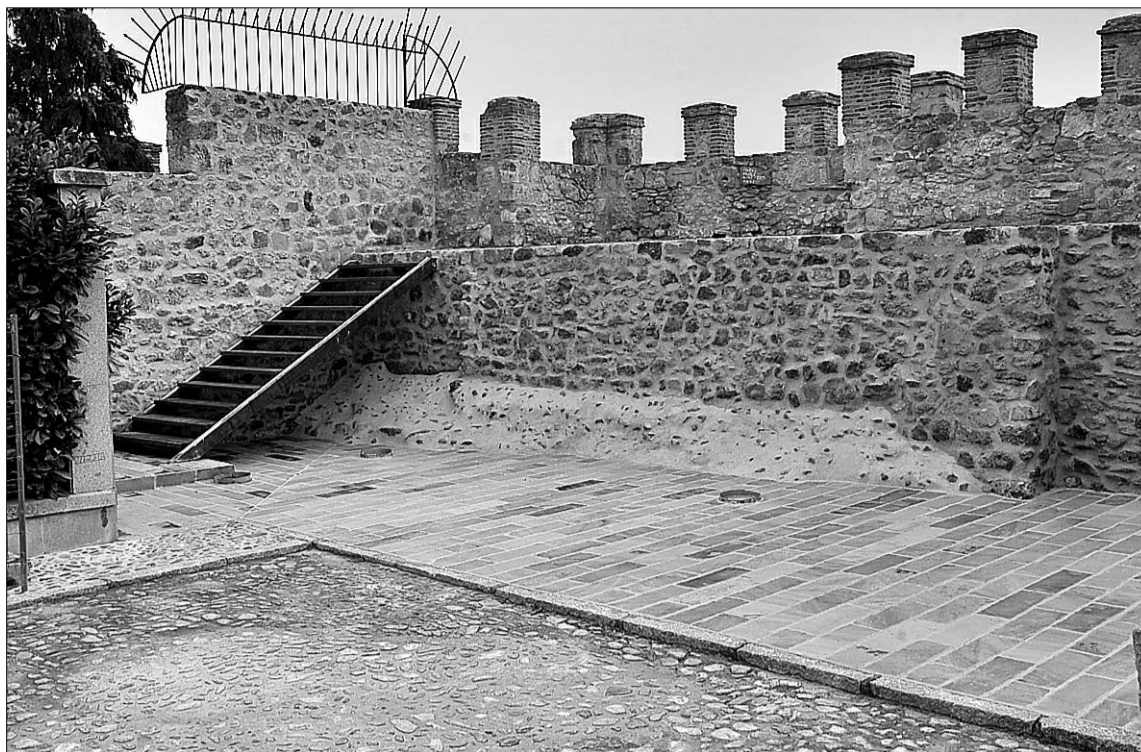
La escalera de acceso al adarve ha sido reubicada en una zona lateral de la plazuela. / KAMARERO
