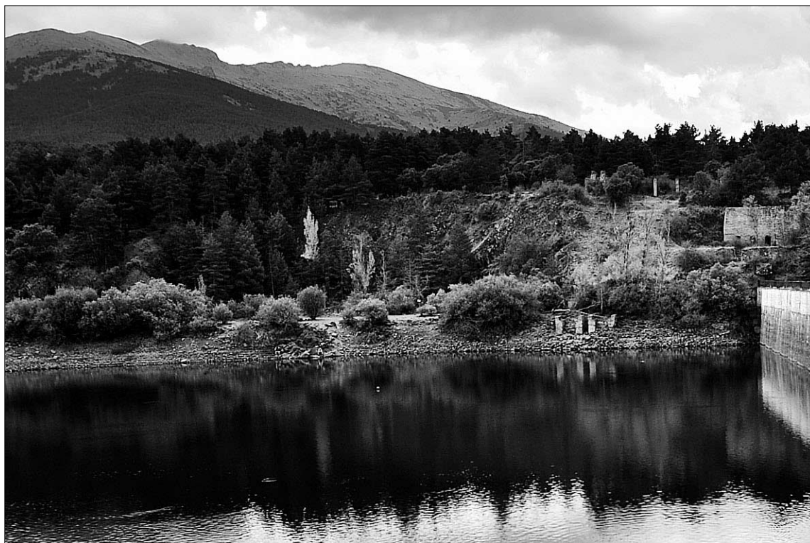
La presa de Puente Alta, en Revenga, de titularidad municipal, se construyó en la década de los años 50. / KAMARERO
