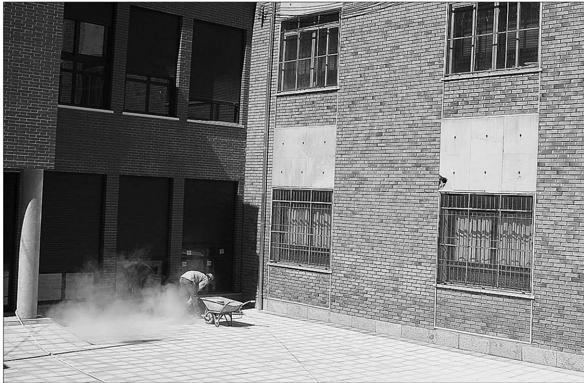
El CEIP "Diego de Colmenares" vio reparado el muro perimetral, a la espera de la intervención en el patio. / KAMARERO
