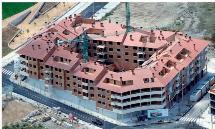
"MANZANA GOLDEN", Edificio de 86 viviendas, locales, garajes y trasteros.
