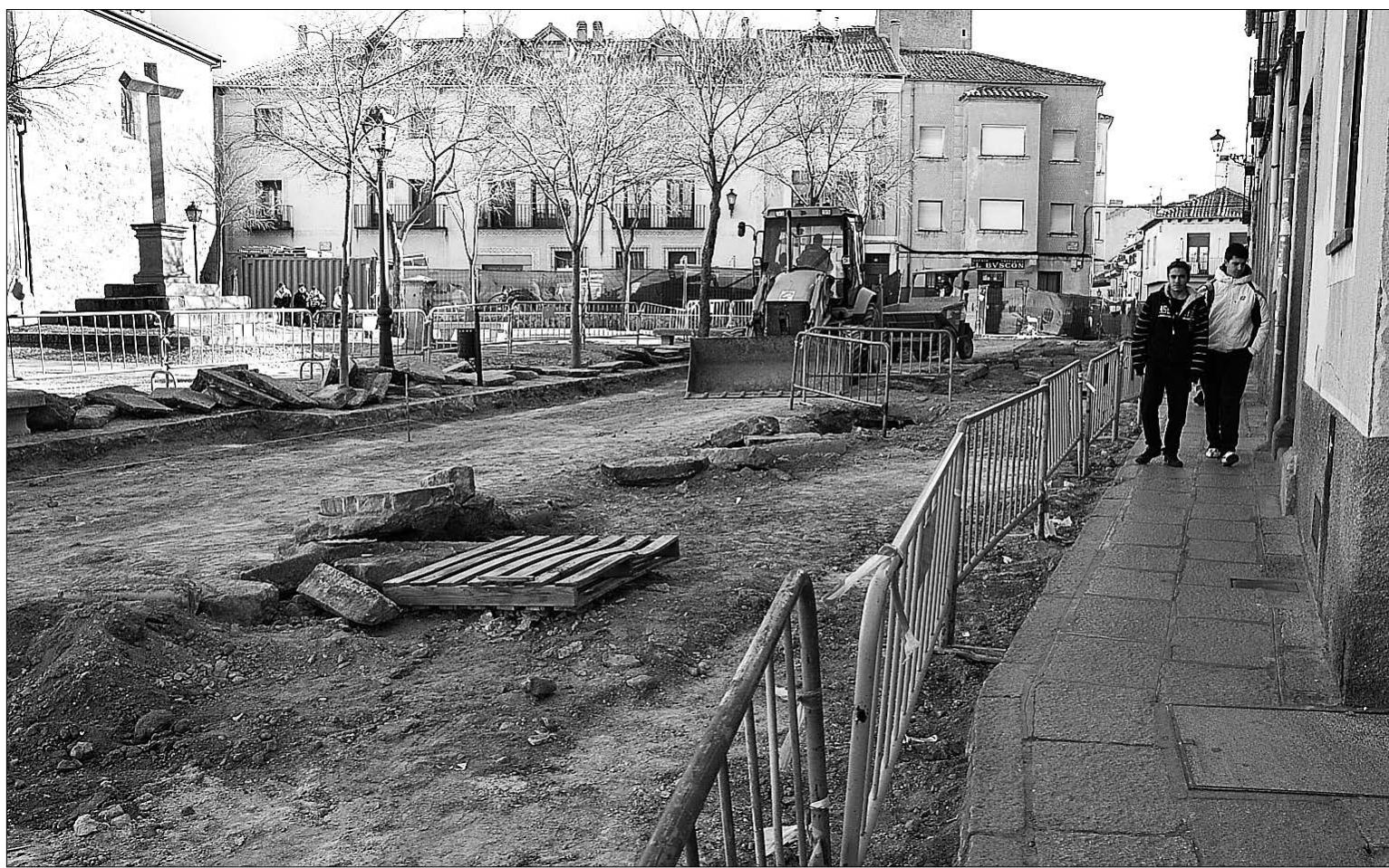
Los trabajos que se están ejecutando han obligado a cortar el tráfico, un corte que aún se prolongará por espacio de algo más de un mes. / JUAN MARTÍN
