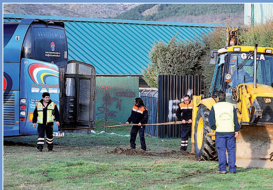
La excavadora tuvo que remolcar durante algunos metros a un autocar. /KAMARERO
