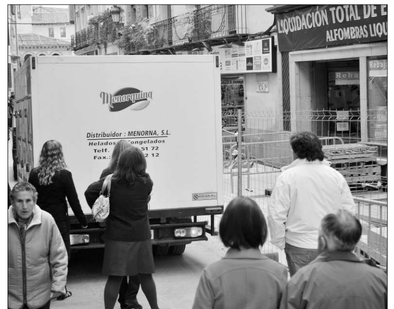
Las obras en la Calle Real se iniciaron hace más de tres meses/PEÑALOSA
