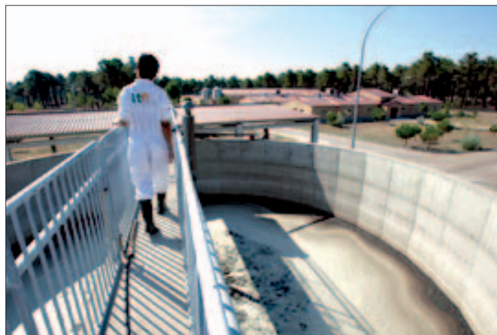
El Centro cuenta con una balsa de tratamiento de purines. / ITACYL
