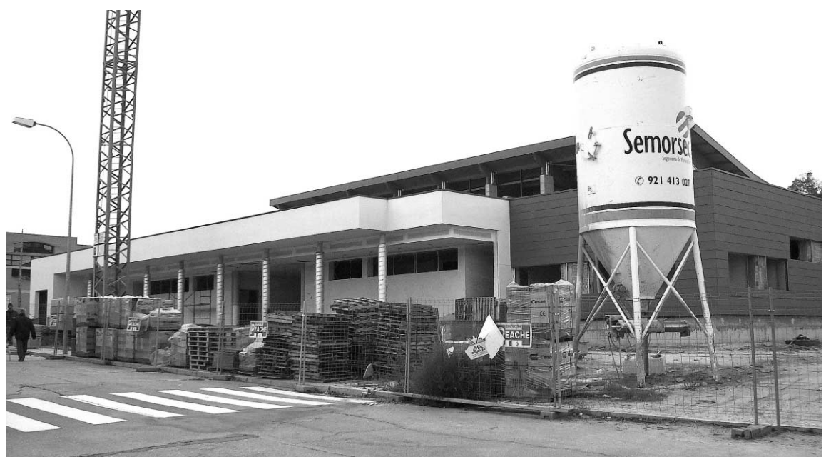
Actual aspecto que presentan las obras de la futura piscina cubierta de Cantalejo / C. V.
