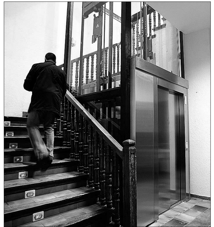
Nuevo ascensor instalado en el edificio con 500 años de historia./ KAMARERO
