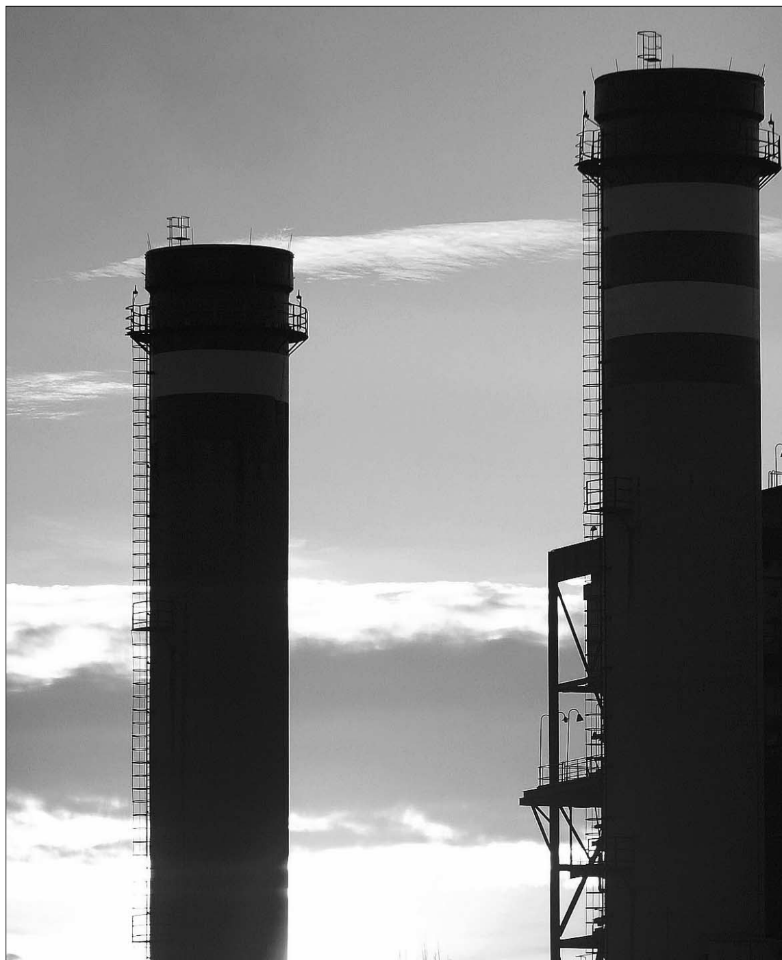
Imagen de una central térmica productora de electricidad. / DAVID PÉREZ
