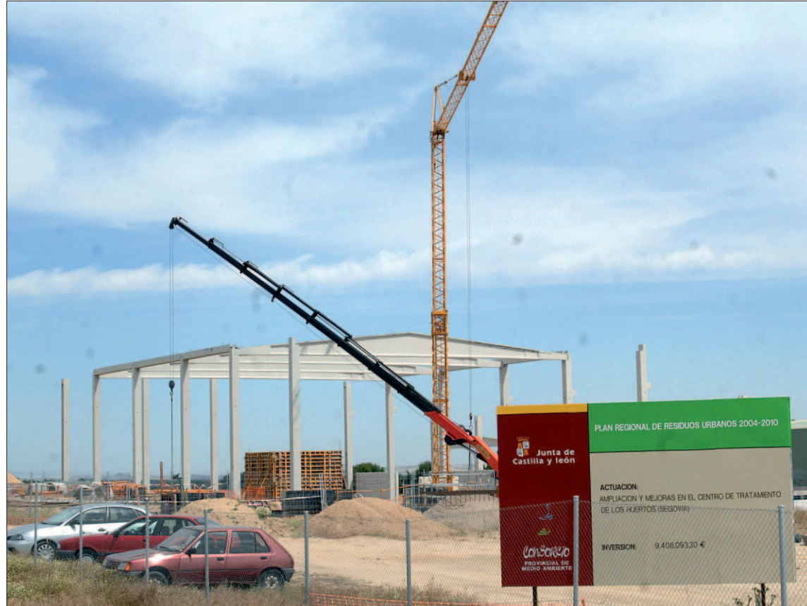
Ampliación de la planta de Tratamiento de residuos de los Huertos
