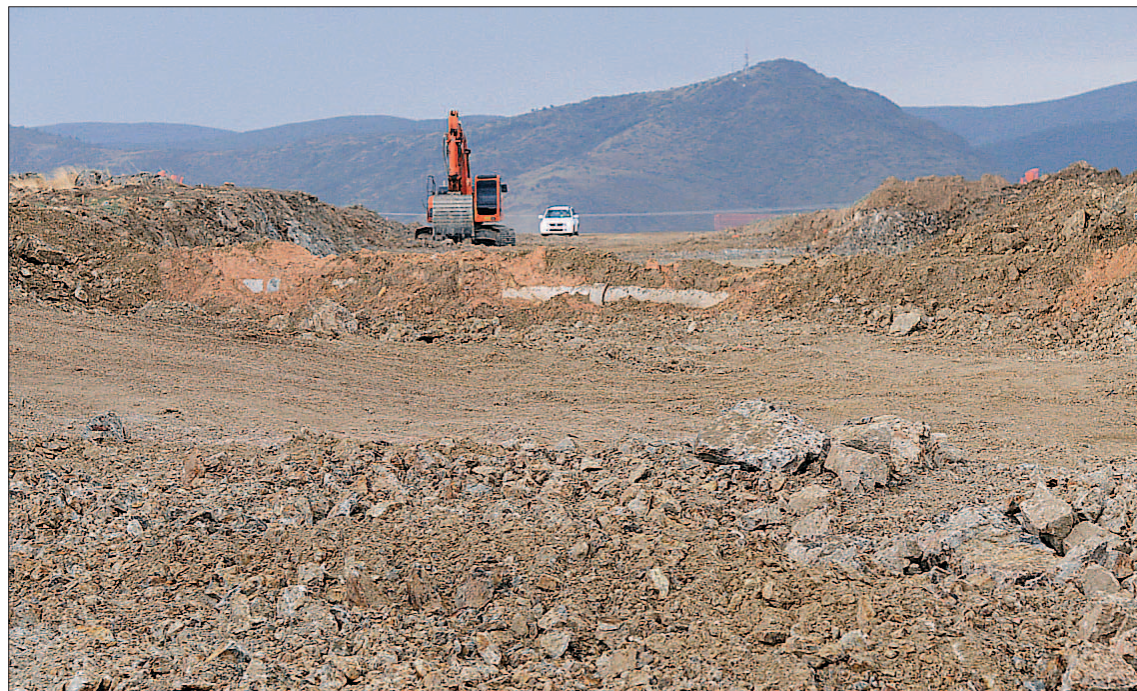
Estado actual de las obras de acceso a la estación de alta velocidad de Segovia. / BEATRIZ VELASCO
