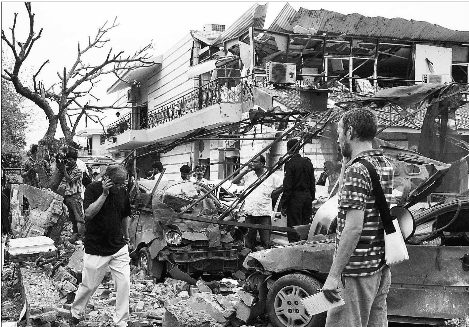
La explosión causó notables destrozos en la embajada danesa y también en varios edificios cercanos. / OLIVIER MATTHYS (EFE)
