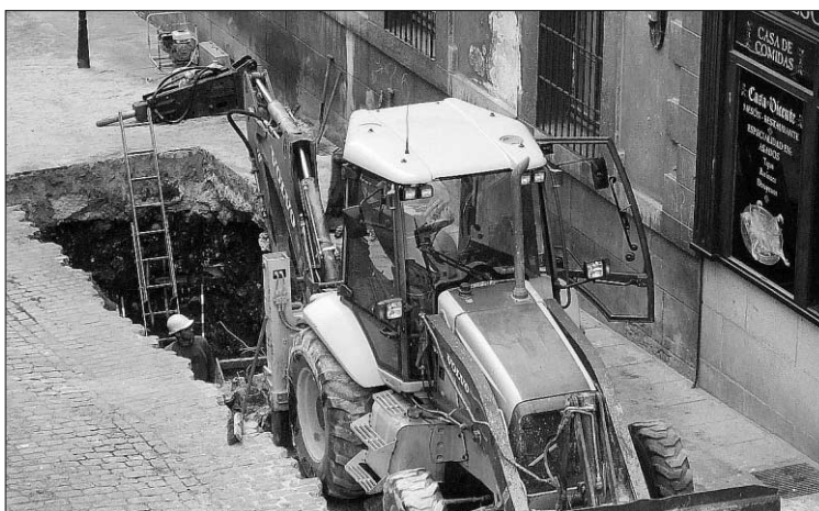
Imagen, tomada ayer, del hueco para los contenedores en la calle Serafín/A.M.
