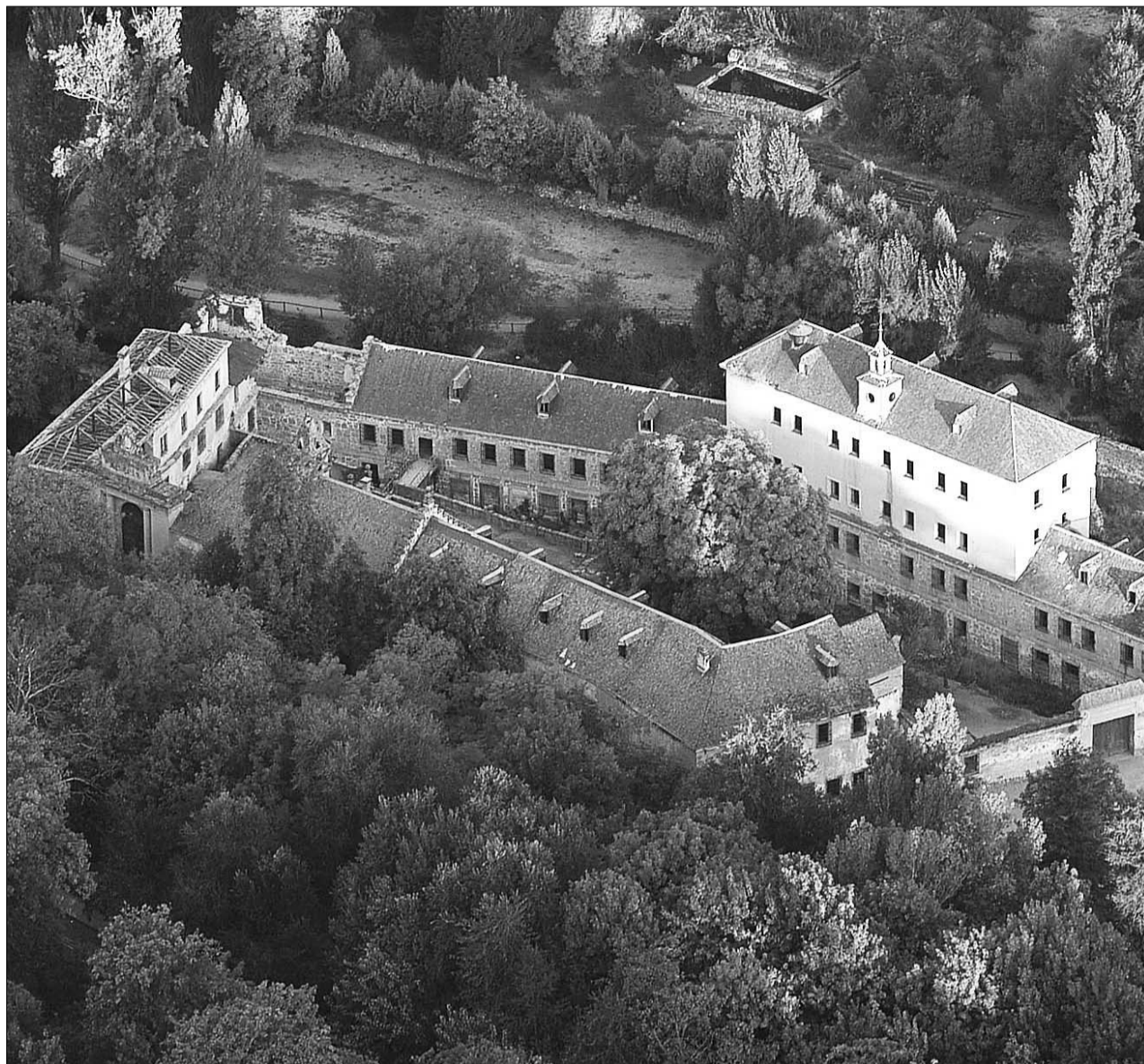
El alcalde confía en que las obras de rehabilitación de la Ceca puedan comenzar en enero; el plazo de ejecución es de 25 meses, por lo que l
