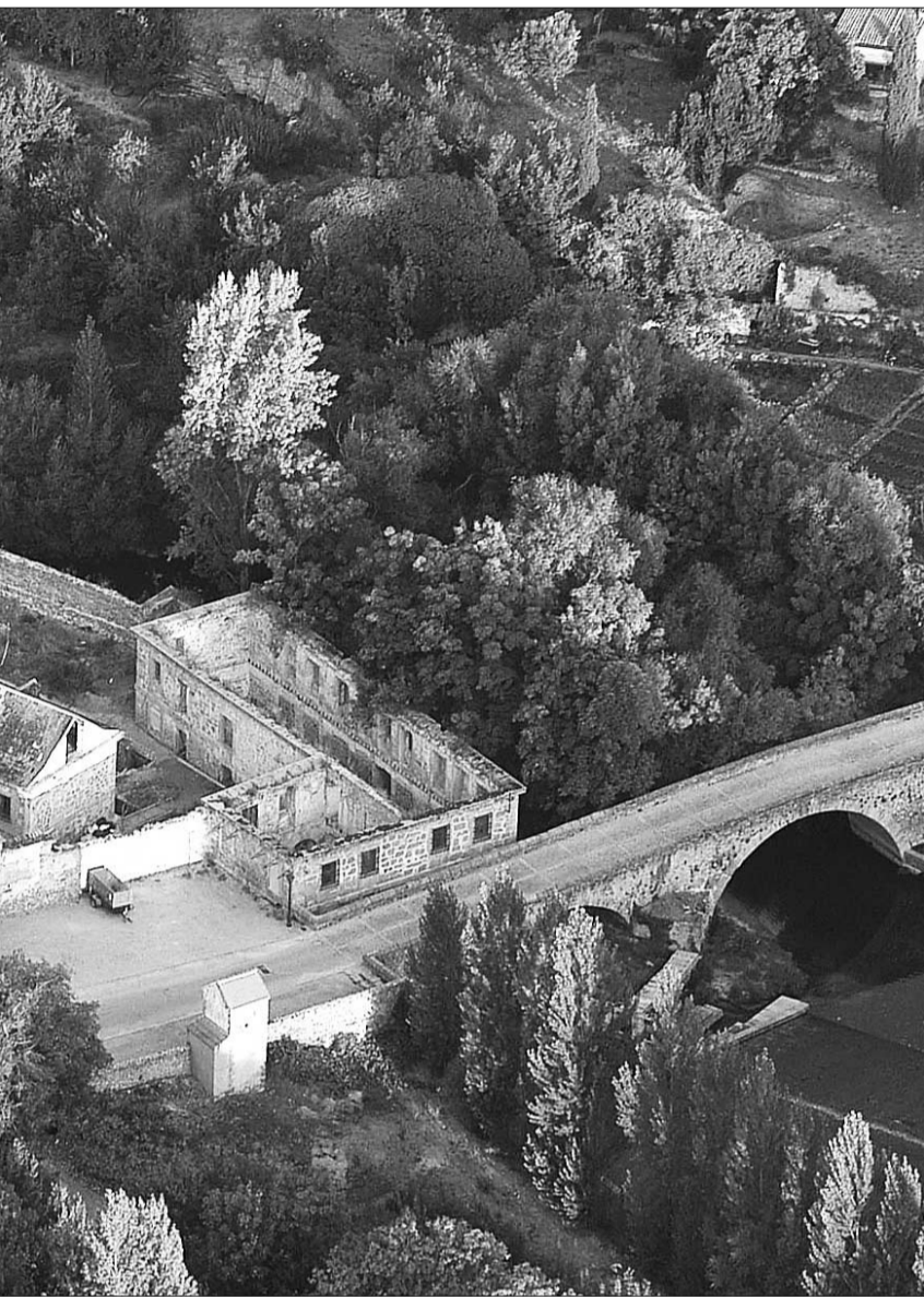
Los trabajos no estarían concluidos al menos hasta febrero de 2009. / JUAN MARTÍN
