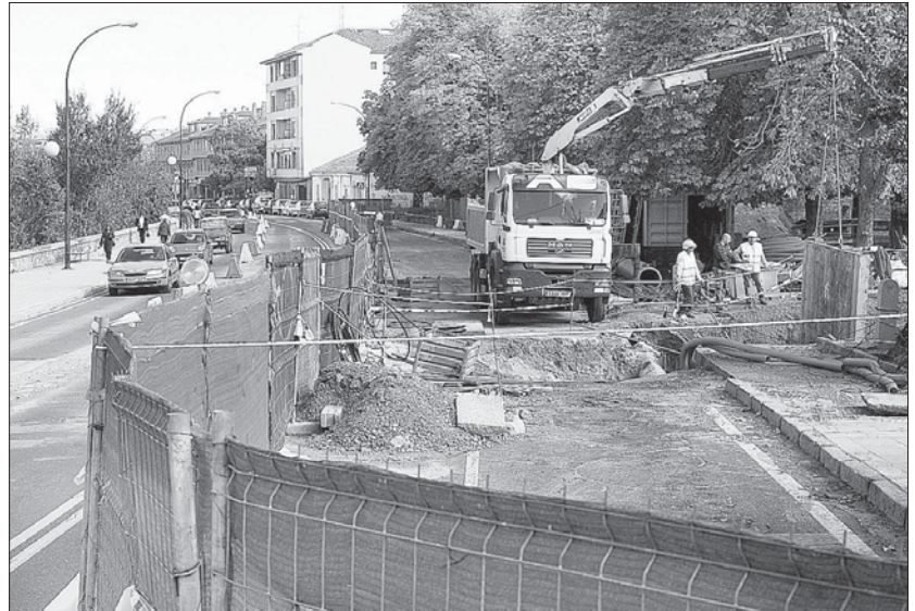
Imagen, ayer, de las obras de sustitución del colector de Vía Roma, a la altura de la Alamedilla del Conejo./KAMARERO
