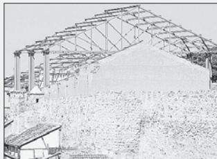
Obras, paralizadas, en el Teatro Cervantes.
