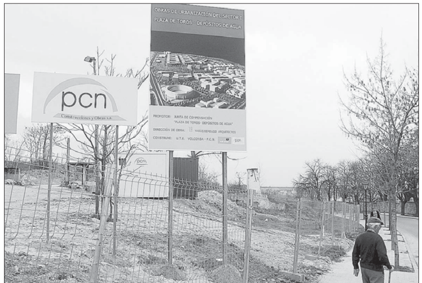
Las obras de urbanización del sector 1 - Plaza de Toros están siendo ejecutadas por Volconsa y PCN. / KAMARERO
