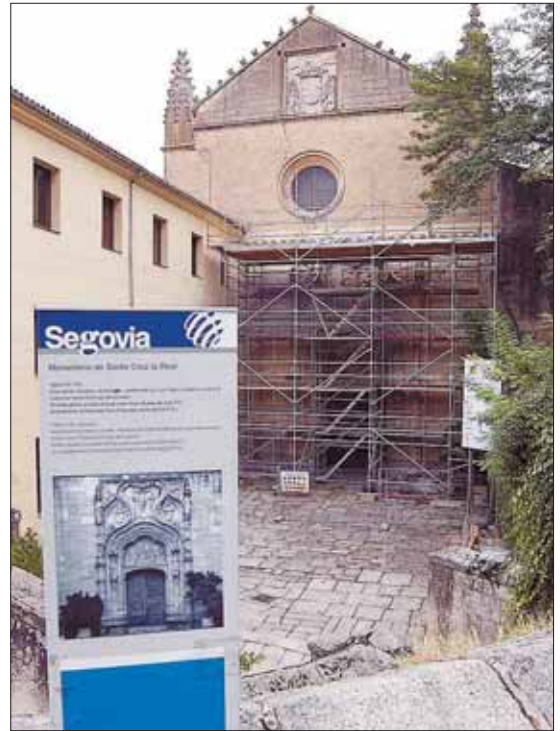
Las obras en la fachada del convento están muy próximas a terminar. JUAN MARTÍN
