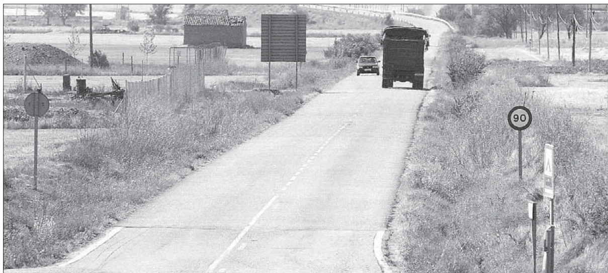
Carretera autonómica ubicada en la localidad palentina de Torquemada. / CÉSAR MANSO
