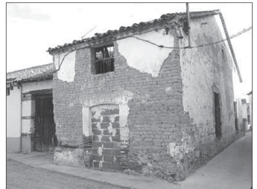
Estado actual del edificio que será rehabilitado./
