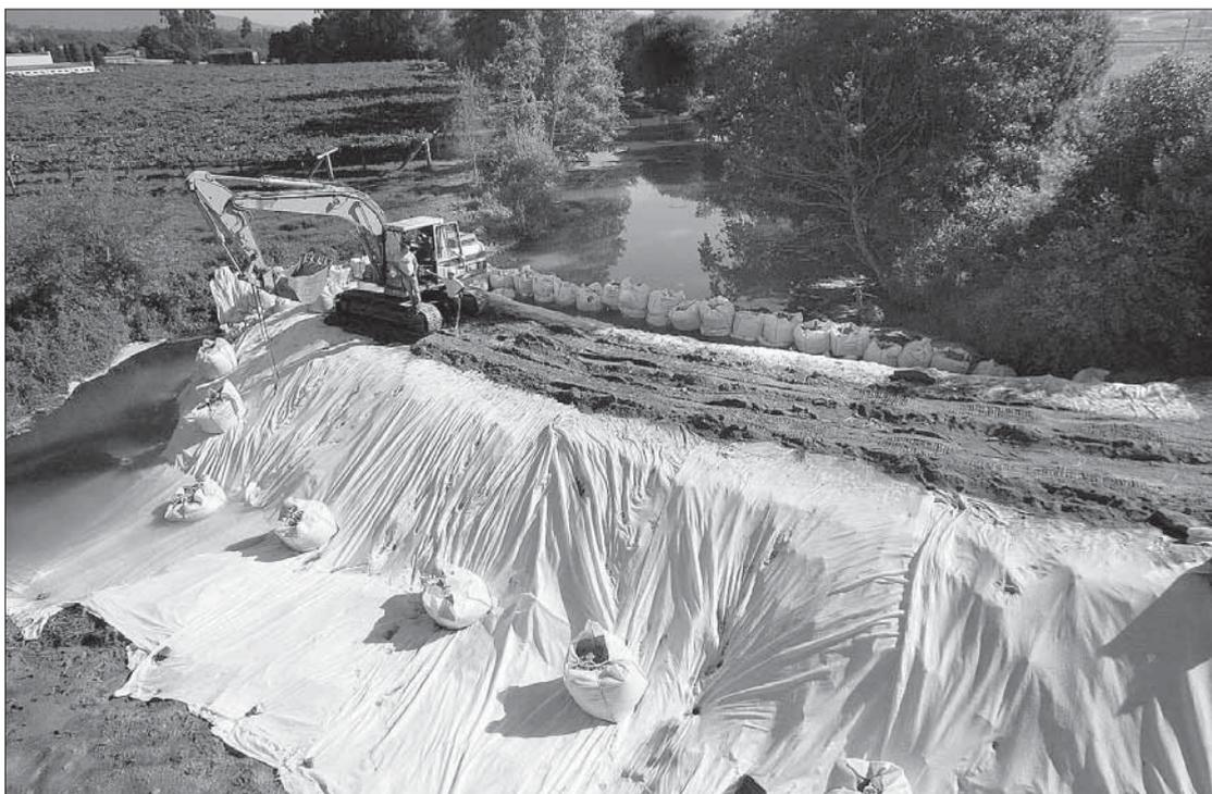
Una excavadora realiza trabajos de construcción de un dique para retener el vertido que baja por el río Umia tras el incendio registrado el viernes en Caldas de Reis. / EFE
