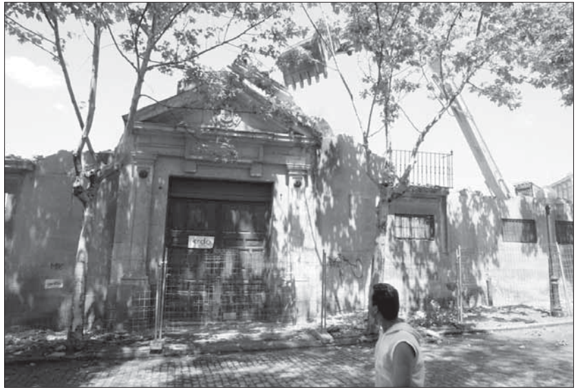
Los muros perimetrales del antiguo acuartelamiento van desapareciendo ante los ojos de los segovianos./PEÑALOSA
