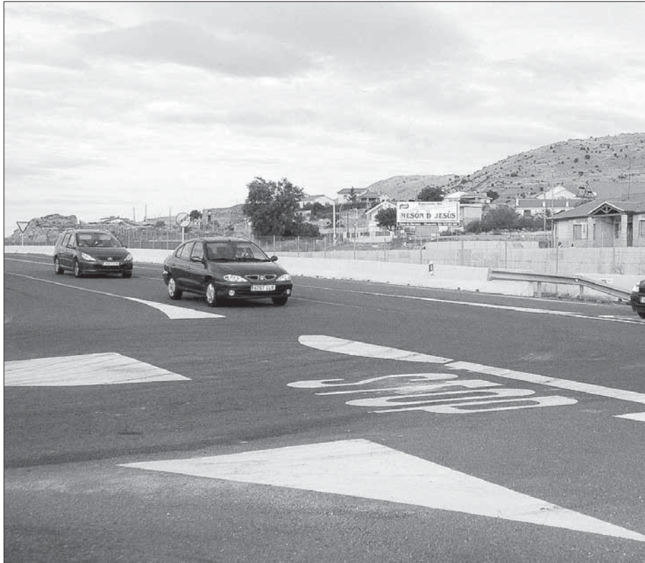
Espacio que ocupará la futura rotonda de la N-603 [Segovia-San Rafael], en el cruce con la provincial SG-P-722, a su paso por el municipio de Otero de Herreros
