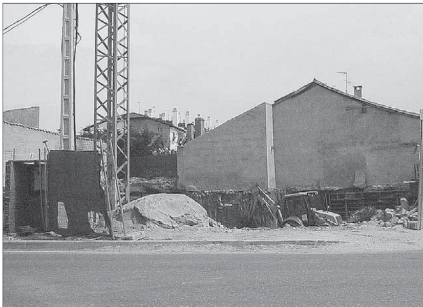
Imagen de la obra de la que los cuatro detenidos sustrajeron el material. / FERNANDO PEÑALOSA
