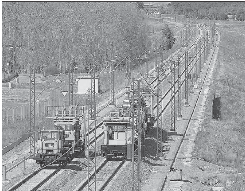
Imagen de archivo de las labores de colocación de catenarias en un tramo de la provincia de Segovia/PEÑALOSA
