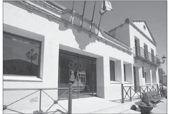
Fachada del Ayuntamiento de Valverde del Majano. / F. PEÑALOSA
