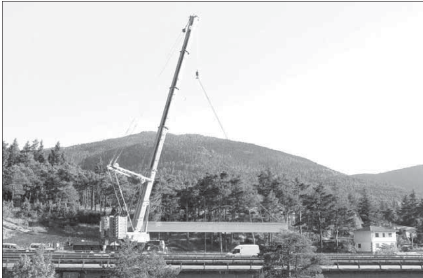
En los últimos días se han colocado grandes vigas con motivo de las obras del nuevo viaducto de la autopista. / PEDRO L. MERINO
