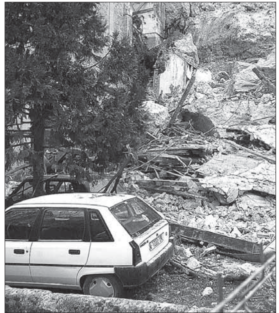
Imagen del coche que sufrió los desperfectos tras el derrumbe./JUAN MARTÍN
