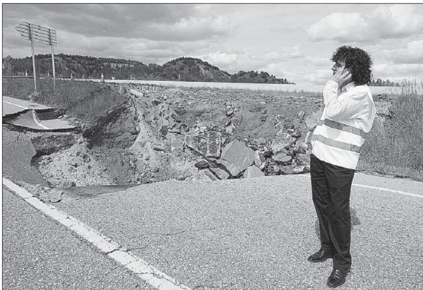
Los operarios encargados del arreglo de la carretera confían en que esté acondicionada para hoy. /F. PEÑALOSA
