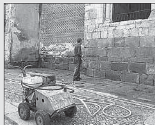
ACM trabaja en la limpieza de los muros/J.M.
