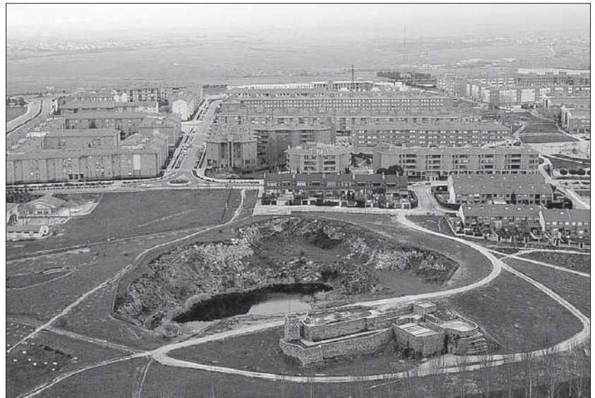
Vista aérea de la cantera de la Romera, situada en la Dehesa del Alto Clamores, en Nueva Segovia. / A. MARTÍN
