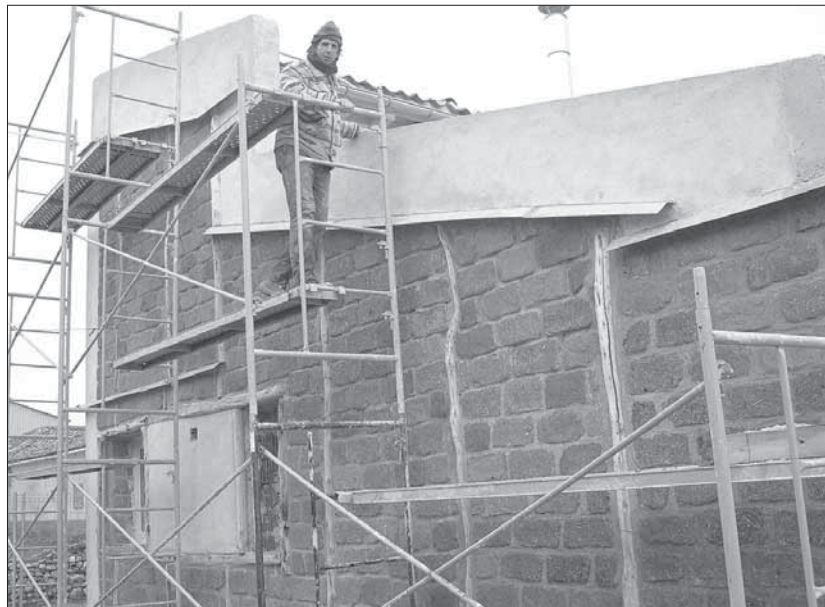
Construcción de una vivienda bioclimática en Riahuelas en la que se han usado adobes reciclados.
