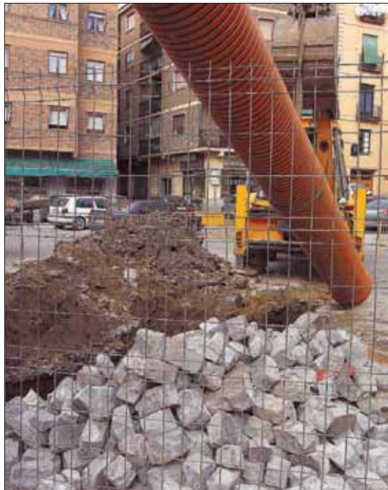
Los trabajos han comenzado en las calles Carmen y Santa Engracia/PEÑALOSA
