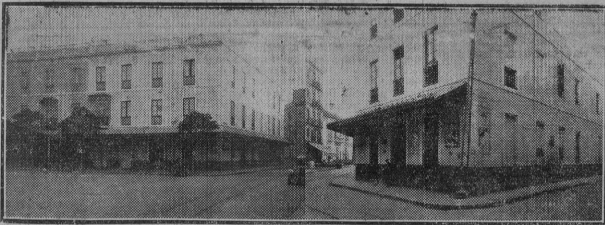
Dos aspectos de la fachada del que fué popular coliseo y cuya demolición tendrá lugar en breve.
