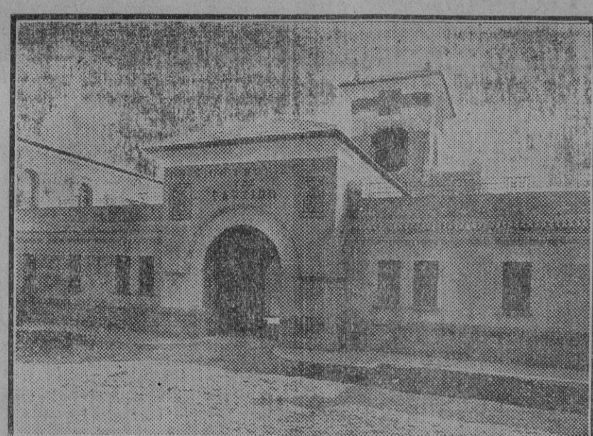
Puerta de entrada á la nueva Prisión Provincial y de Partido.
